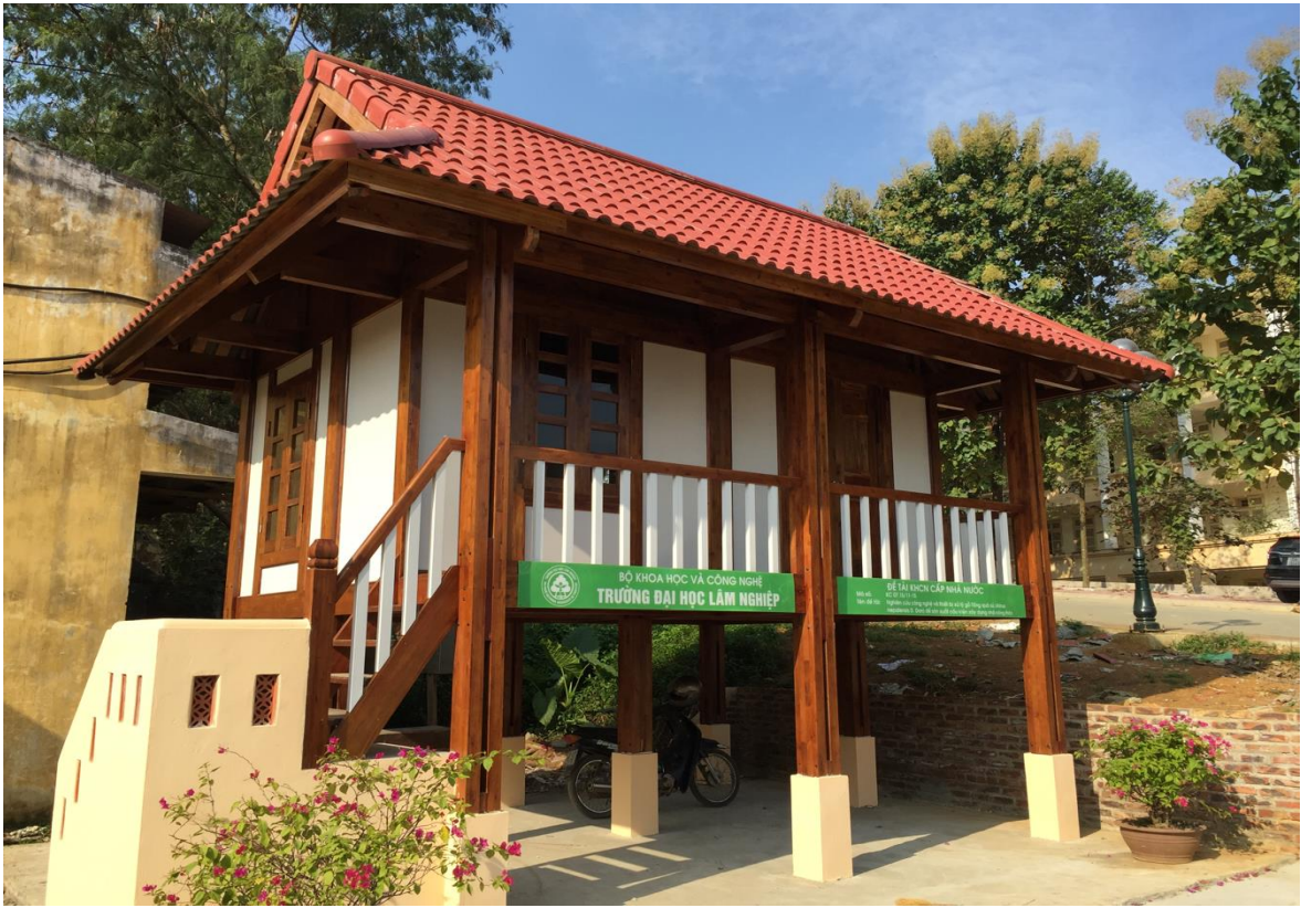
Nhà sàn từ gỗ Tổng quán xử lý thủy - nhiệt - cơ và xử lý bảo quản
